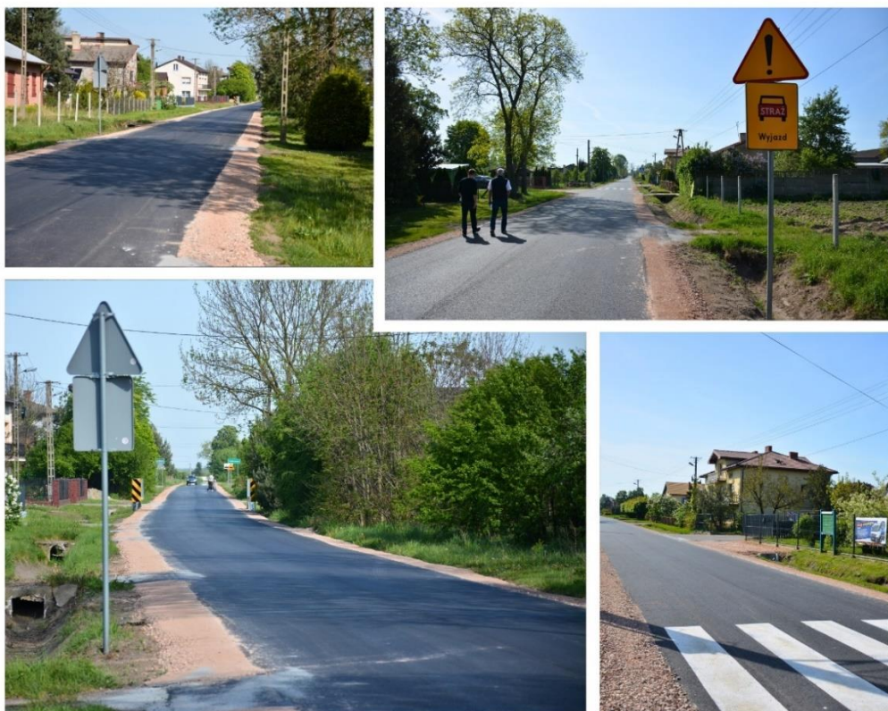
Fot. 16 Przebudowa drogi powiatowej nr 5121 E w Boczkach Domaradzkich gm. Głowno.
