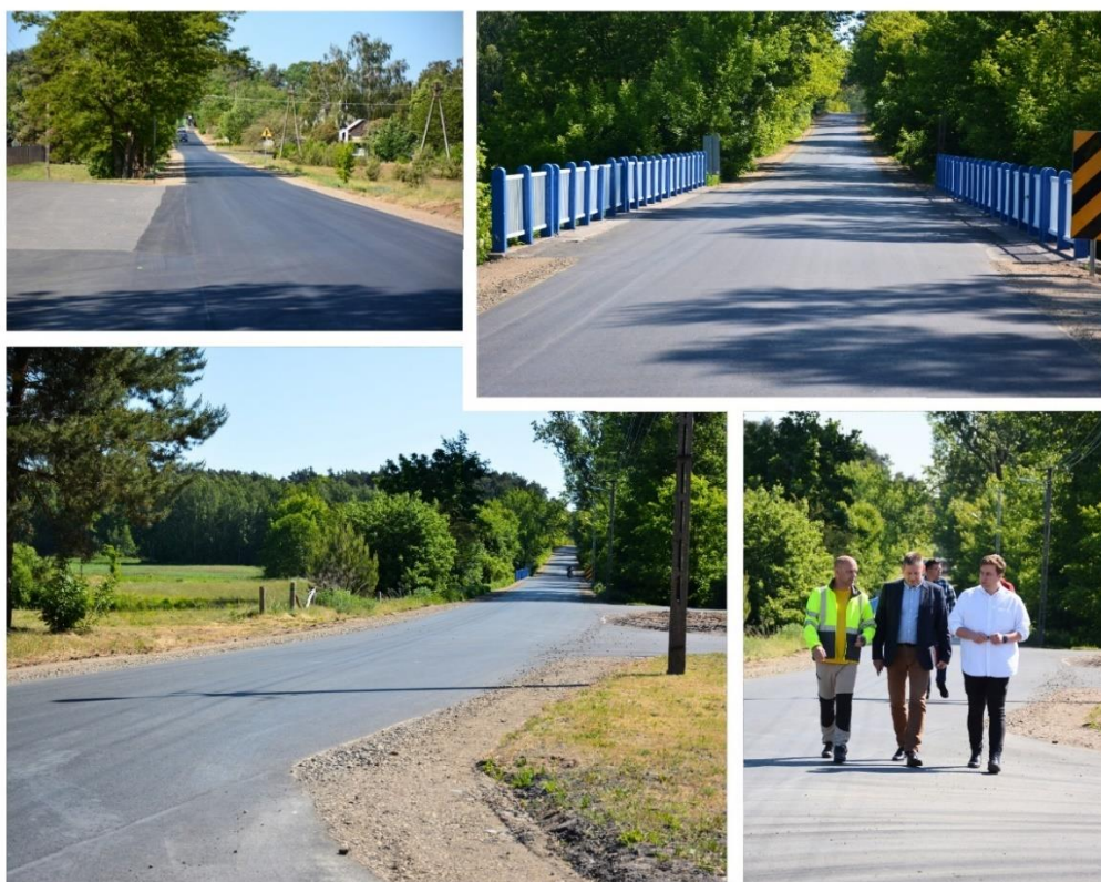
Fot. 17 Przebudowa drogi powiatowej nr 5123 E w Ziewanicach gm. Głowno.
