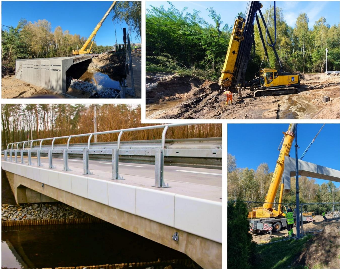
Fot. 11 Budowa mostu przez rzekę Bzurę w miejscowości Ruda Bugaj gm. Aleksandrów Łódzki w ciągu drogi powiatowej Nr 5168 E.
