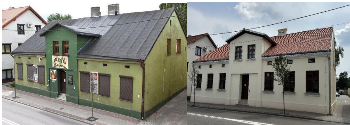
Fot. 3 Siedziba CKPZ przed i po remoncie.
