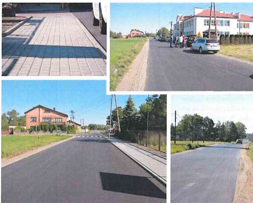
Fot. 12 Przebudowa drogi powiatowej Nr 5106 E w Besiekierzu Rudnym gm. Zgierz.
