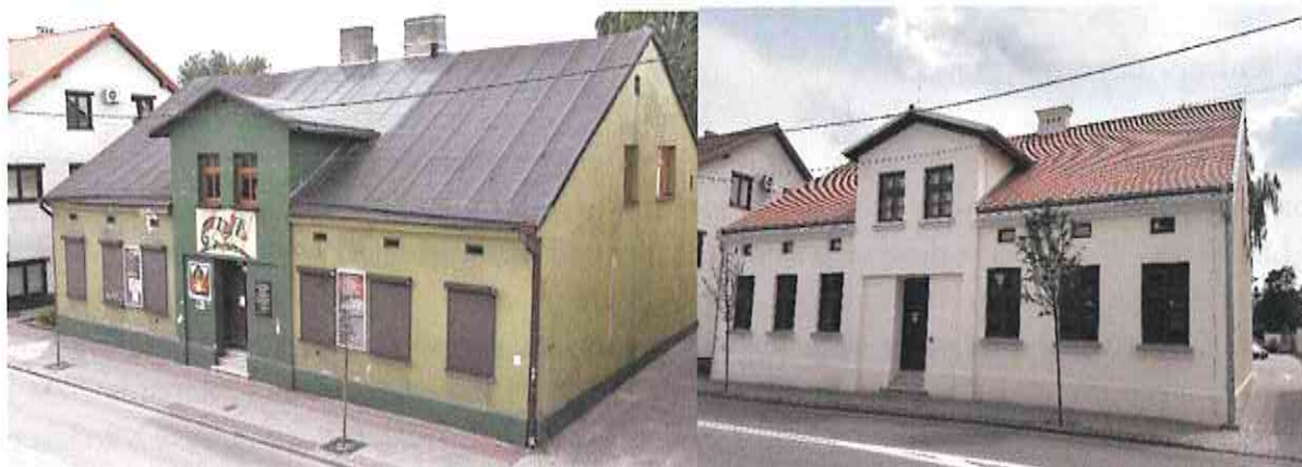
Fot. 3 Siedziba CKPZ przed i po remoncie.
