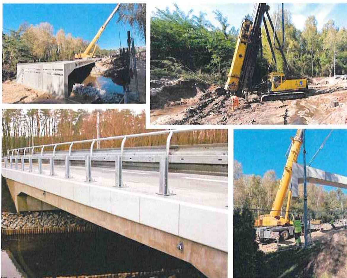
Fot. 11 Budowa mostu przez rzekę Bzurę w miejscowości Ruda Bugaj gm. Aleksandrów Łódzki w ciągu drogi powiatowej Nr 5168 E.
