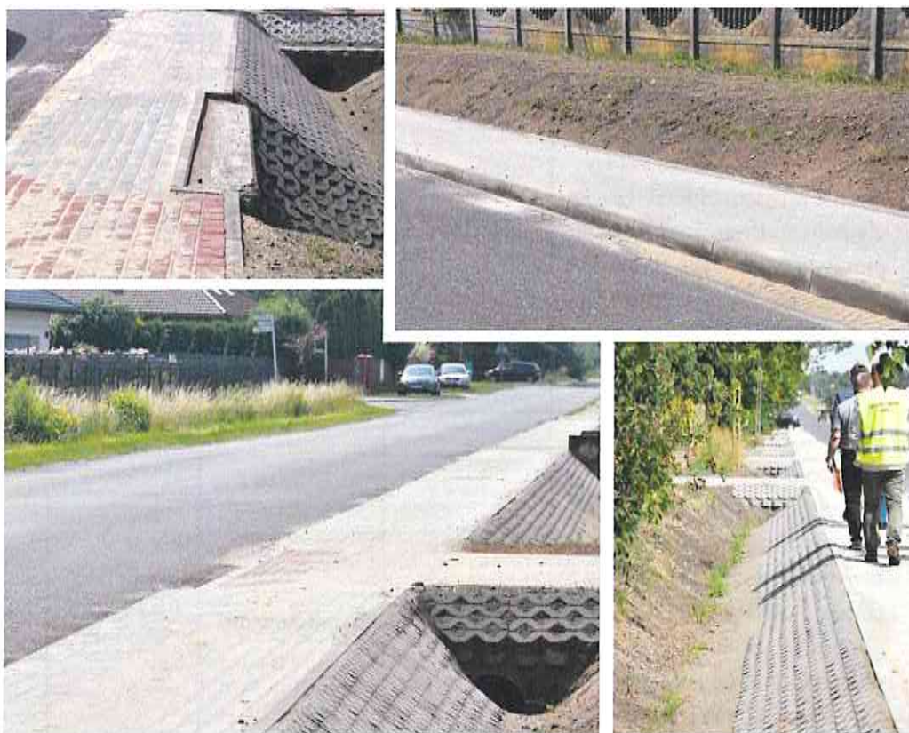
Fot. 14 Budowa drogi dla pieszych w miejscowości Śliwniki gm. Ozorków.
