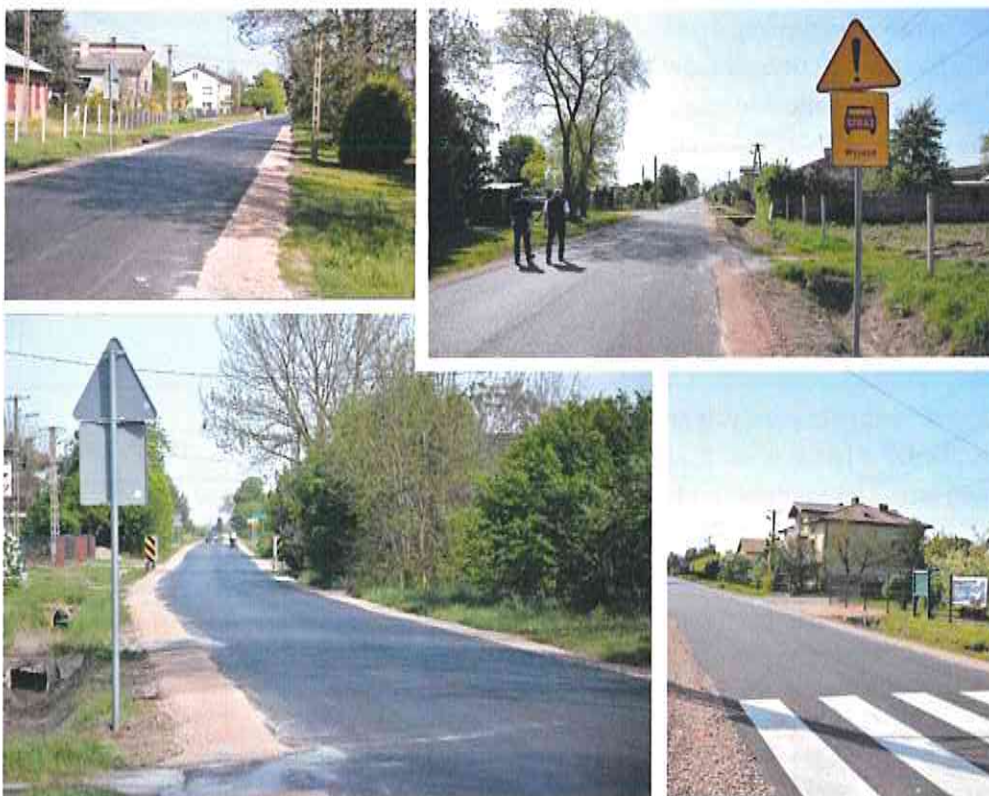
Fot. 16 Przebudowa drogi powiatowej nr 5121 E w Boczkach Domaradzkich gm. Główno.
