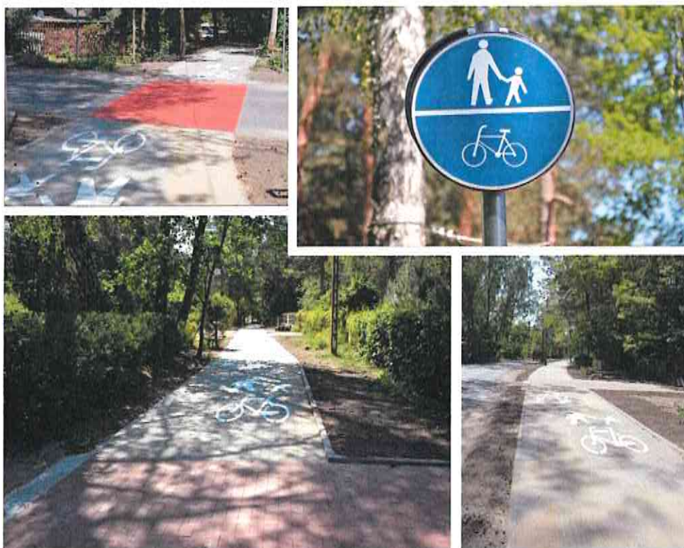
Fot. 13 Budowa ciągu pieszo – rowerowego na terenie powiatu zgierskiego – przy drodze DP 5167 E w granicach adm. m. Jedlicze gm. Zgierz.
